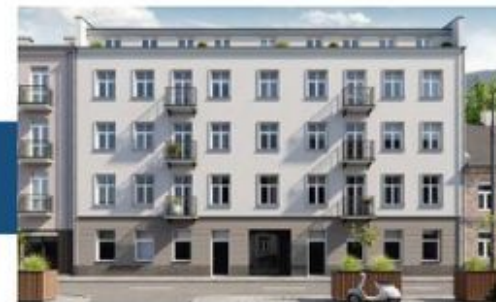
Widok budynku od strony ulicy
