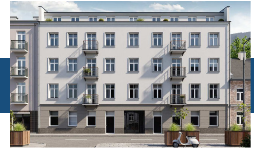
Widok budynku od strony ulicy
