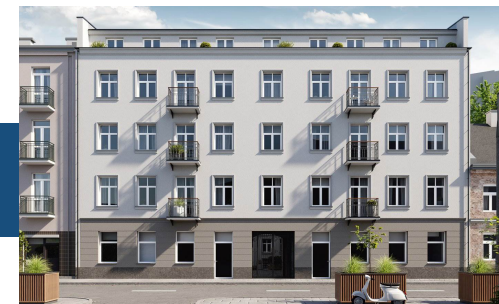
Widok budynku od strony ulicy
