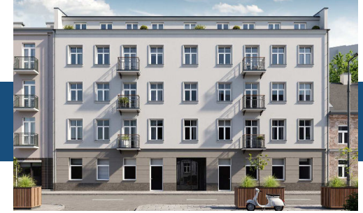
Widok budynku od strony ulicy
