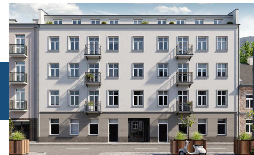
Widok budynku od strony ulicy
