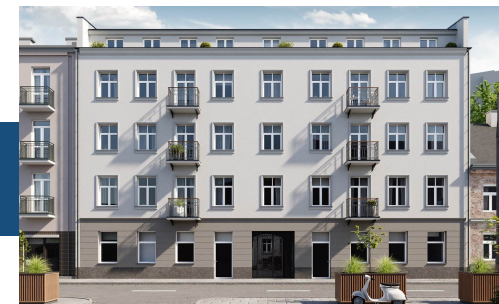
Widok budynku od strony ulicy
