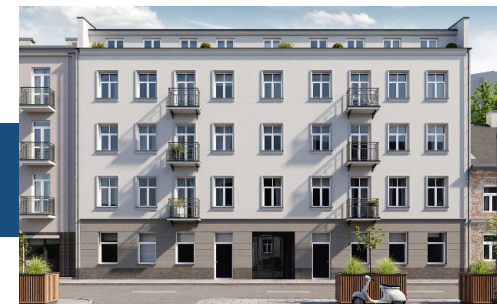
Widok budynku od strony ulicy
