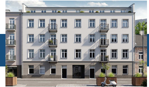
Widok budynku od strony ulicy
