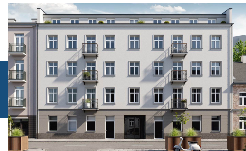
Widok budynku od strony ulicy
