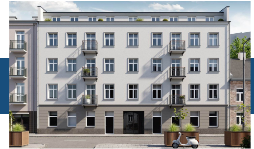
Widok budynku od strony ulicy
