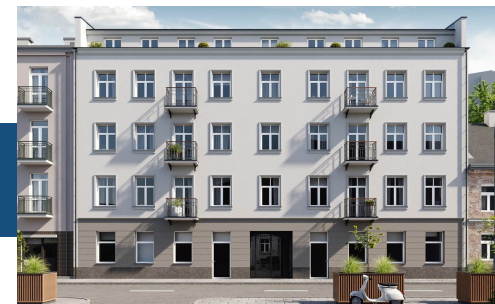
Widok budynku od strony ulicy
