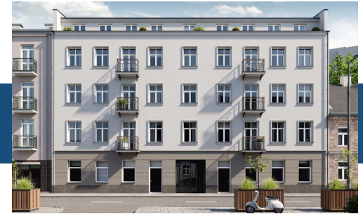
Widok budynku od strony ulicy
