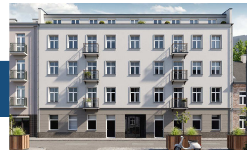
Widok budynku od strony ulicy
