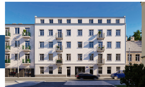
Widok budynku od strony ulicy
