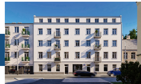
Widok budynku od strony ulicy
