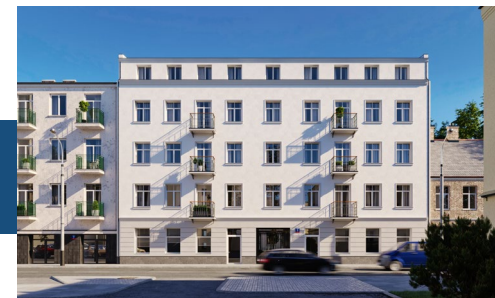
Widok budynku od strony ulicy
